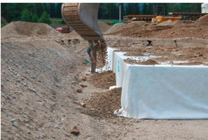
Überdecken Sie das Boxenvolumen mit feinem Kies und verdichten Sie erst ab 30 cm Überdeckung über den Boxen mit einer Rüttelplatte bis 400 kg sorgfältig.
