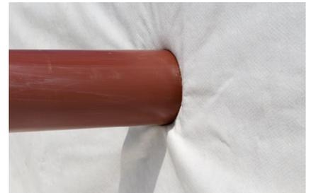
**Achten Sie bei Verwendung von Kunststofffolien auf einen dichten Anschluss der Zu- und Ablaufleitungen.**
