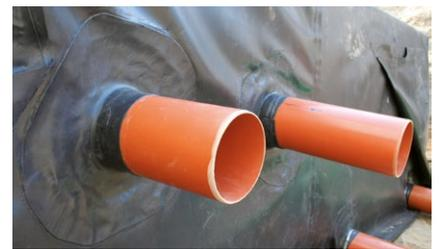
Bei der STORMBOX II wird auf gleiche Weise vorgegangen. Anstelle die Rohre selbst in die Box einzubinden werden die „Seitenplatten für Rohranschlüsse“ eingehängt und dann das jeweilige Rohr darin eingebunden.
