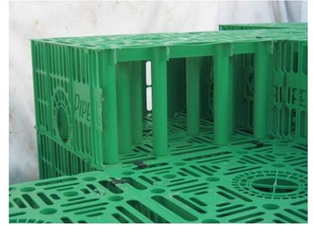
Achten Sie besonders darauf, dass alle STORMBOX-Elemente exakt übereinander stehen und richtig miteinander verbunden sind. Überstände sind in keiner Richtung erlaubt! Damit ist gewährleistet, dass alle auftretenden Kräfte über die Blockwände und Verstärkungssäulen aufgenommen und abgeleitet werden können.
