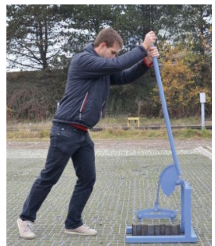
Einfacher Austausch eines Steins mit dem GMS-Zieher
