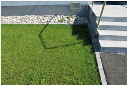
Die Versickerungsanlage trägt durch ihre Begrünung zum CO 2 -Abbau bei.
