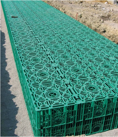
Bei geringer Durchlässigkeit des Bodens empfiehlt Pipelife den zusätzlichen Einsatz der Raineo Stormbox.
