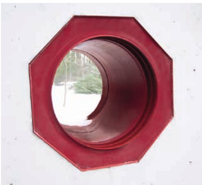
RDS evolution fertig einbetoniert.
