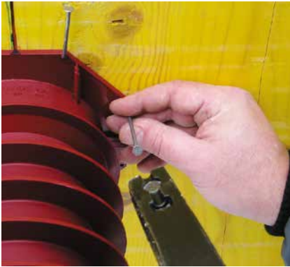
Das Lamellenrohr an die Schalungswand annageln.
