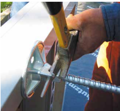
Zweite Schalungswand aufstellen, Schalungsanker anziehen.
