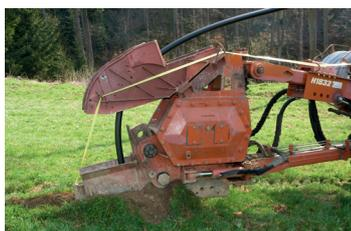
Beim Pflügen wird der **Boden ohne Aufbereitung** verdrängt. Daher müssen dafür **Rohre mit einem sehr guten Schutz gegen Punktlasten** verwendet werden. PE KANAL RC Rohre von Pipelife erfüllen mit ihrer nachgewiesenen hohen Spannungsrissbeständigkeit die Ansprüche dieser Verlegungsmethode mit einem Höchstmaß an Sicherheit. Darüber hinaus haben sie auch die für diese Technik erforderliche **Flexibilität**. Das Pflügen stellt wohl die wirtschaftlichste Neuverlegung von Kunststoffrohren dar.
