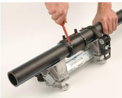
Schieben Sie die Elektroschweißmuffe bis zum Mittelanschlag oder zur markierten Einstecktiefe auf das zu verschweißende Rohr. Ziehen Sie bei ELGEF Plus Fittings bis OD/DN 63 die Schrauben der integrierten Rohrfixierung an. Montieren und fixieren Sie die Haltevorrichtung. Schieben Sie das zweite Rohr/Formstück bis zum Mittelanschlag oder zur markierten Einstecktiefe ein und fixieren Sie dieses ebenfalls in der Haltevorrichtung. Ziehen Sie die beiden verbliebenen Schrauben fest.
