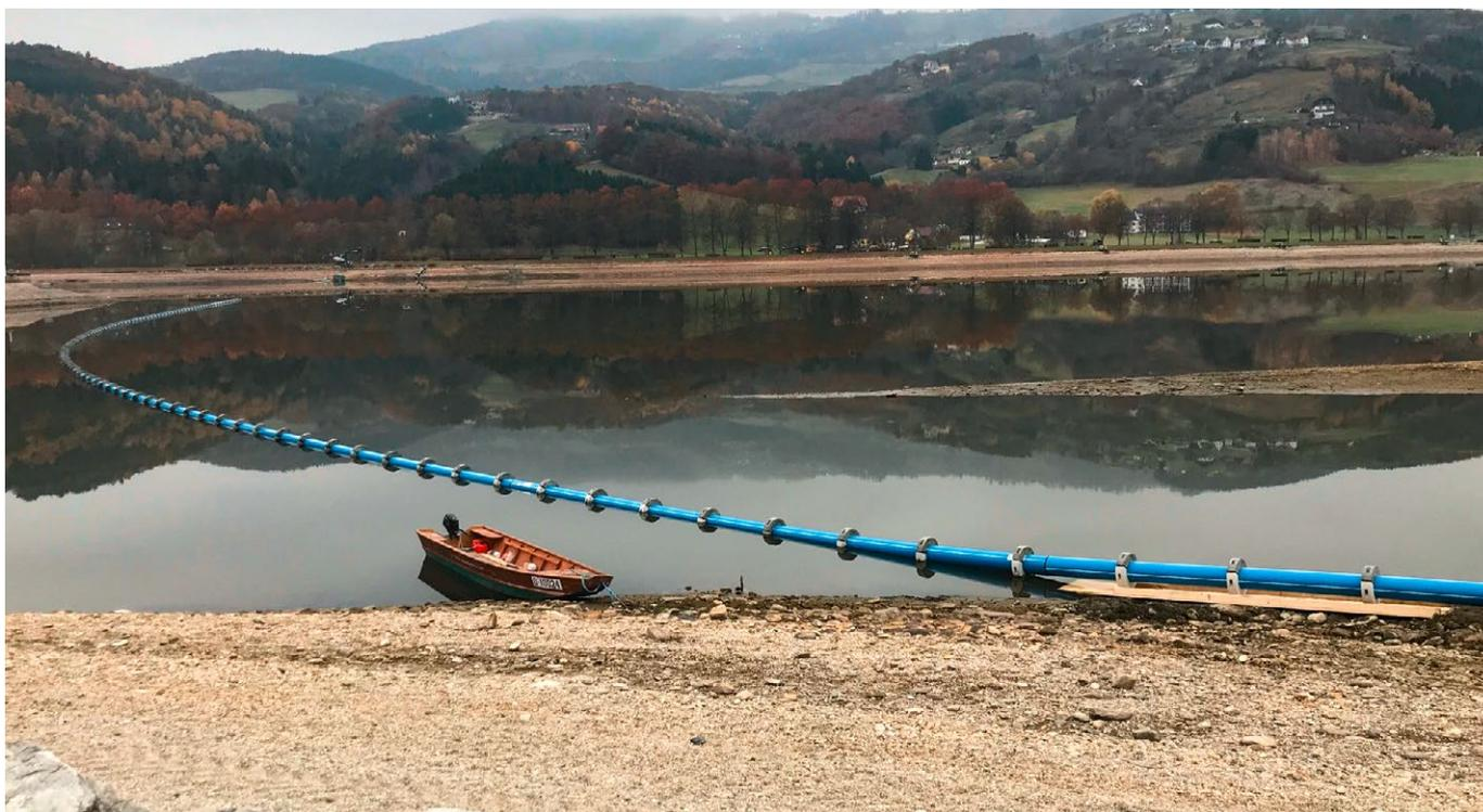
**Über den Winter wurde im Rahmen eines spektakulären Bauvorhabens eine Regenwasserleitung zum Hochwasserschutz durch den Stubenbergsee verlegt. Ein Spezialeinsatz für das AQUALINE RC Robust Rohr von Pipelife.**
