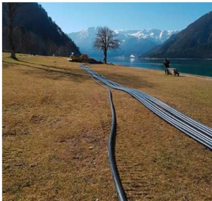
Die in Rollen gelieferten Druckrohre aus PE 100-RC wurden entlang des Sees ausgerollt.
