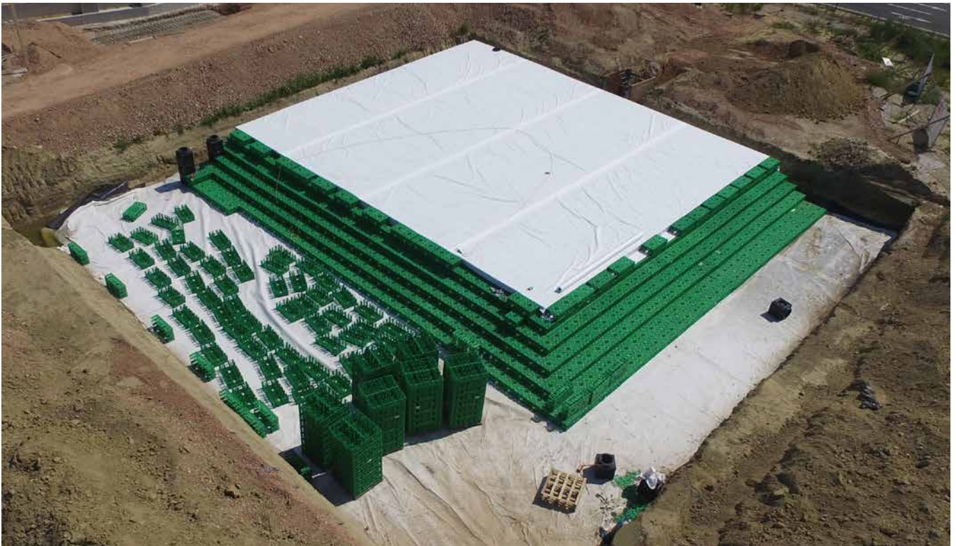
Für die Rückhaltung und kontrollierte Ableitung des Regenwassers beim EKZ Siegendorf kamen knapp 6.000 Stormboxen von Pipelife zum Einsatz.
