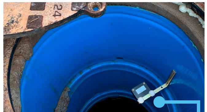
Einfach im Schacht installierbar – der Smart Level Meter
