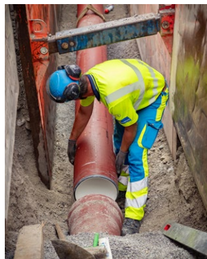
Die Verlegung der Längsentwässerung erfolgt im Huckepack-System.
