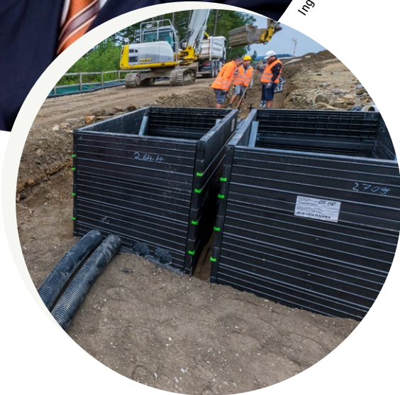
Vormontierte ROM-Box Kabelschächte und Kabelschutzrohre von Pipelife auf der Baustelle S10 in Oberösterreich.
