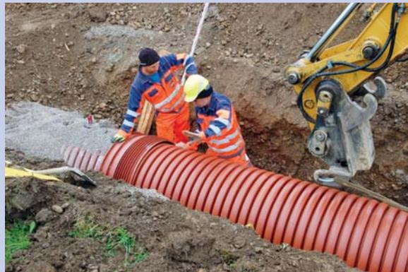
*Das geringe Gewicht der Rohre erleichtert das Handling und die große Baulänge (6 m) erhöht die Verlegegeschwindigkeit. Vor dem Zusammenschieben werden der Dichtring und die Innenseite der Muffe mit Gleitmittel bestrichen.*
