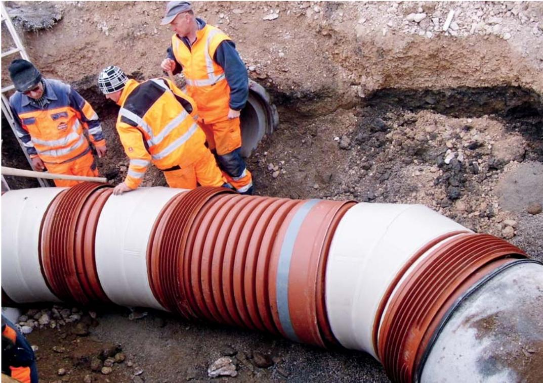
Zu den PP-Großrohren ist ein umfangreiches Formstückprogramm erhältlich. Bei diesem Projekt kamen Bögen mit 15° und 30° sowie Schachtfutter zum Einsatz.
