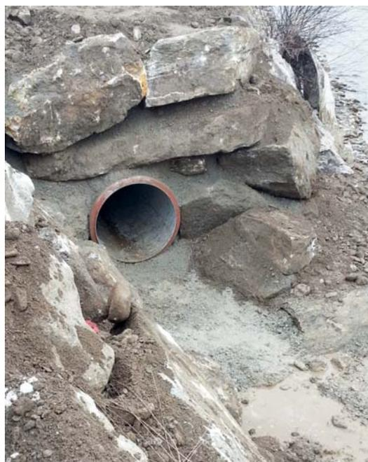
*Pipelife PP-Großrohre besitzen die Steifigkeitsklasse SN8 und können auch bei geringer Überdeckung eingesetzt werden.*
