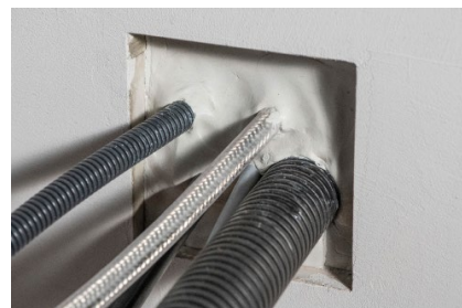
Abdichtung mit SEALTAQ vor Einbringen des Mörtels
