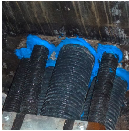
Abdichtung von Mehrfachdurchführungen und Leerverrohrungen
