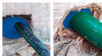
Abdichtung mit DRIFIL
