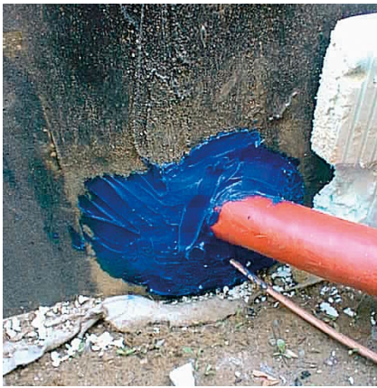
Abdichtung von schräg verlegtem Rohr und Erdungsdraht
