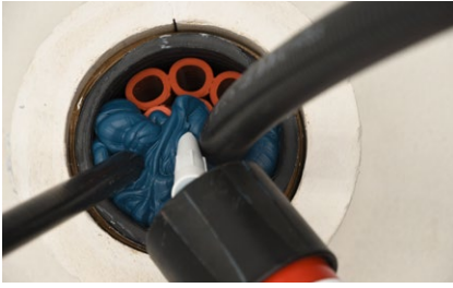
Gesamte Öffnung mit DRIFIL ausfüllen
