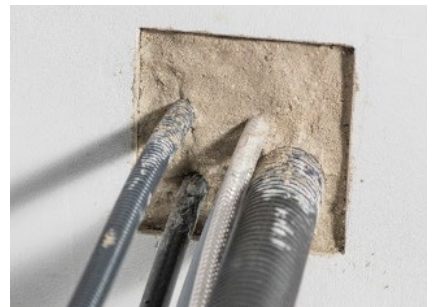
Absicherung der Dichtmasse mit Spezialmörtel FN 1105
