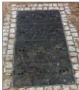
Exakte Niveauanpassung an die Geländeoberkante durch vier Einstellschrauben.
