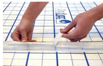
Die Längsfuge zwischen Randdämmstreifen und Pipelife Systemrolle plus wird durch Überlappen des auf dem Randdämmstreifen aufkaschierten Folienstreifens abgedichtet.
