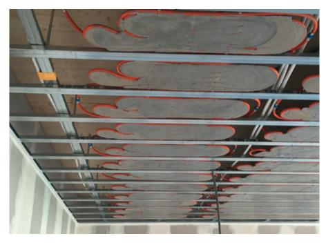
Modul, wobei der Rohrdurchmesser mit 16 mm deutlich größer ist als bei anderen Systemen. Vergleichbare Systeme erbringen Kühlleistungen von 40 bis 60 W/m² bei gleichen Rahmenbedingungen.
