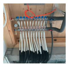
Die 320 m² große Kühldecke besteht aus 63 Heiz/Kühlkreisen. Dafür wurden 446 Stk. Bluebee Module, 300 lfm Radopress-Mehrschichtverbundrohre in DA 20 mm (für die Zuleitungen) und 500 Stk. Radopress-Fittings sowie 6 Edelstahlverteiler benötigt.
