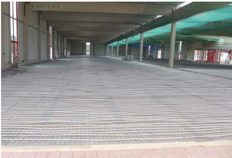
Der Baumarkt umfasst eine Nutzfläche von ca. 8.000 m<sup>2</sup>. Für die Industrieflächenheizung wurden hier 33.600 Laufmeter FLOORTHERM Mehrschichtverbundrohre verlegt.
