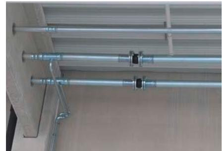
Die Heizungsanbindung erfolgt mit dem C-Stahl-System C-PRESS in den Dimensionen Da 18 bis 108 mm.
