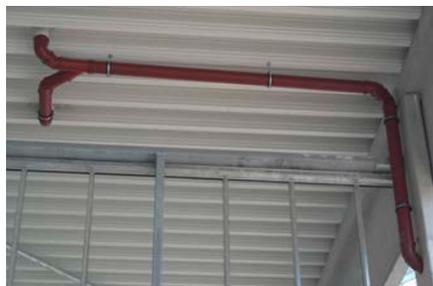
Das robuste MASTER 3-System kommt hier in der Dimension Da 125 für eine Regenwasserleitung zum Einsatz.
