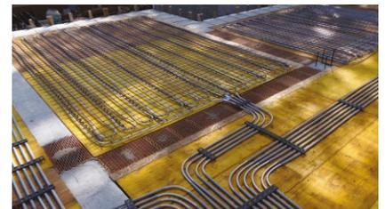
Vorgefertigte Module mit SLAB16 System
