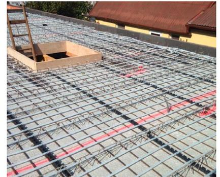
Verlegung vor Ort: Rohrregister auf Filigrandecke mit Schienenbefestigung
