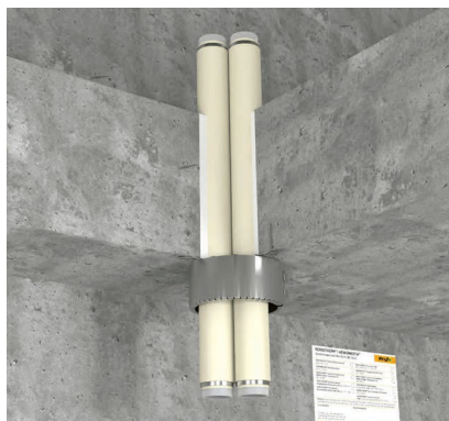
Abbildung 29: Deckendurchführung ohne Dämmung
