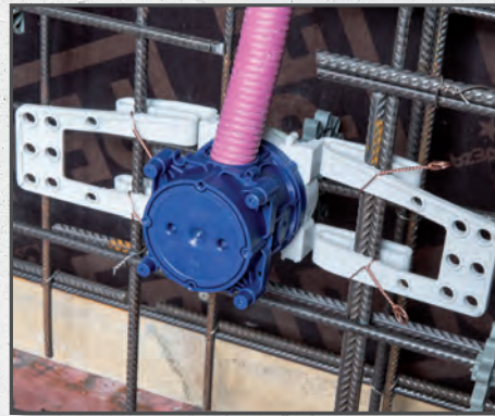
Sichtbeton zur Gegenschalung ohne Abstützung - keine Stützholme oder Blindsockel erforderlich.
