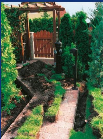
Hier werden die Rohrleitungen den Weg entlang geführt. Zuvor wurden Rasenziegel ausgestochen.
