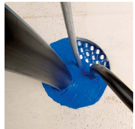
Abdichtung von mehreren Rohren und Kabeln mit DRIFIL
