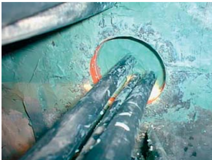
Abdichtung einer Mehrfachdurchführung in einem glatten Rohr
