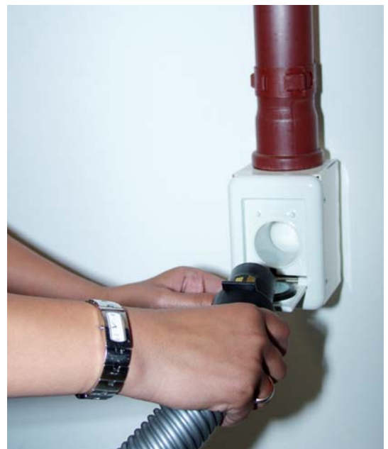
Üblicherweise werden die Dosen und Zuleitungen unter Putz verlegt. Für die Montage in Fertigbetonkellern sind aber auch Aufputz-Dosen erhältlich.
