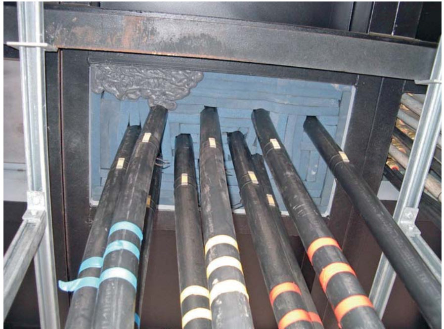
Aufbau einer Mehrfachdurchführung mit Brandabschottung ACTIFOAM und
