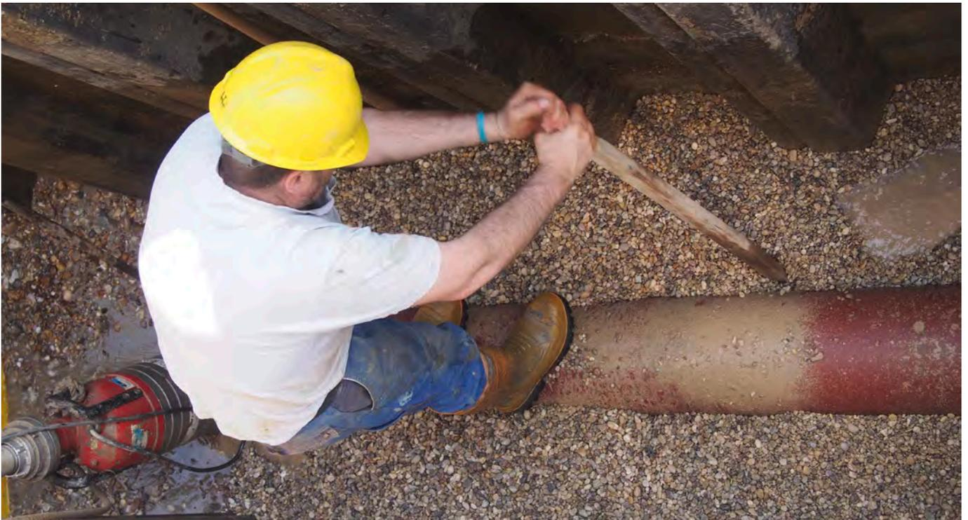
Bettungsmaterial wird seitlich neben bzw. unter der Rohrleitung eingebracht und verdichtet („Zwickelverdichtung“).
