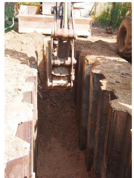
In einigen Abschnitten muss bei der Verlegung mit Spundwänden und Pumpen gearbeitet werden, um den Wassereintritt zu beherrschen.
