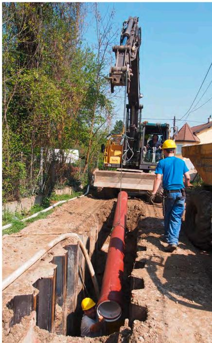
*Trotz der hohen Steifigkeit ist PP MASTER als Kunststoffrohr leicht und somit einfach in der Handhabung*
