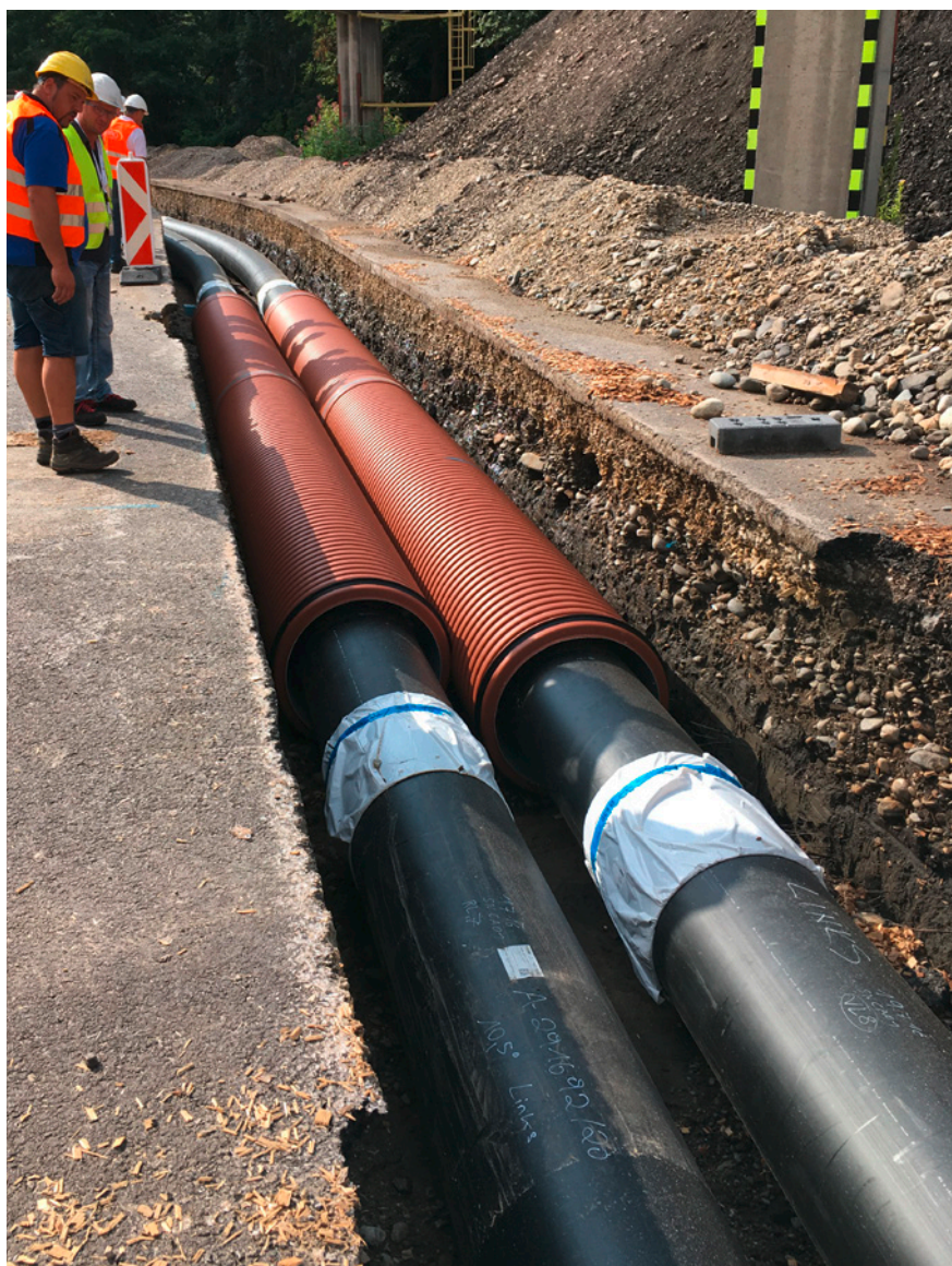
Bei Weg- und Bachquerungen wird die Fernwärmeleitung durch PP-Großrohre von Pipelife geschützt.
