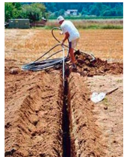
Verlegung mit Erdfräse
